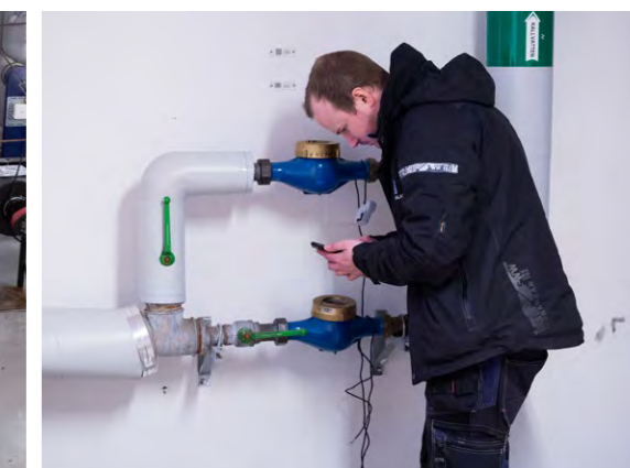
IBLAND SYNS INTE ALLT I DATAPROGRAMMEN OCH PONTUS ÅKER UT PÅ PLATS OCH LÄSER AV KALL- OCH VARMVATTEN DIREKT I EN UNDERCENTRAL I ETT AV VÅRA HUS.
